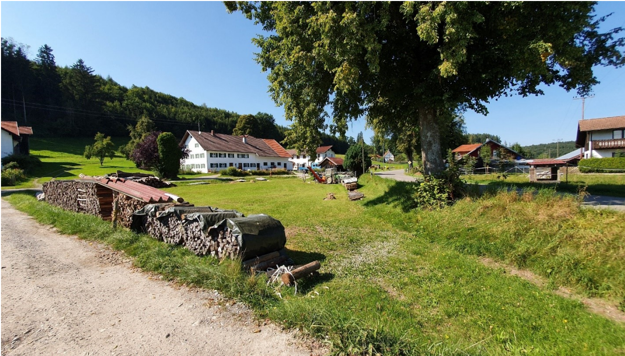
Abb. 27 Tiefelage des Flurstückes 201 durch Anheben der Schloßbergstraße
